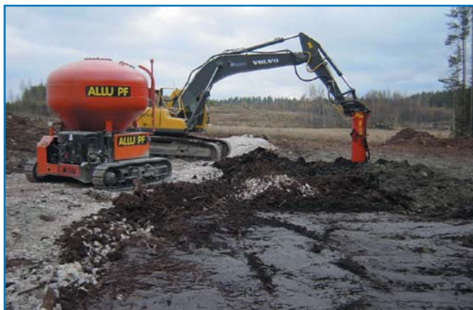
Figura 1 - Il miscelatore ALLU PM Power Mix montato su un escavatore Volvo opera la miscelazione della calce e del cemento con la torba. La miscela calce e cemento viene fornita dall'alimentatore a pressione ALLU PF (in colore rosso). Dopo solo un giorno, la torba è già in grado di sostenere il carico dei mezzi di cantiere pesanti.
